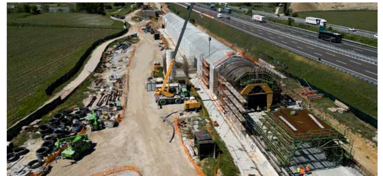
Cantiere di Ferroberica: galleria artificiale per la TAV Brescia-Verona a Peschiera del Garda (VR)
